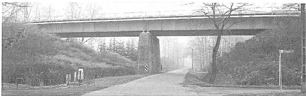
Rys. 1. Widok od strony zachodniej na most pod torem nr 1
