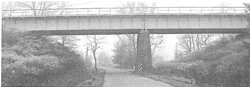
Rys. 2. Widok od strony wschodniej na most pod torem nr 2
